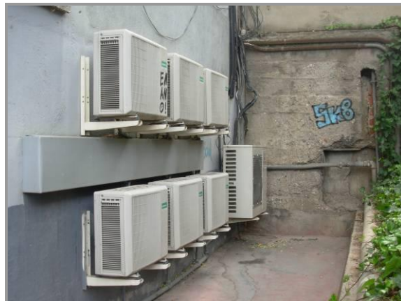
Figura 11 Equips exteriors unitats d'aire condicionat i un compressor per la sala del servidor informàtic.
