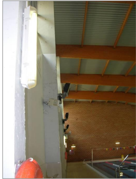
Figura 8 Piscina climatitzada: Paret d'obra a vista, sostre metàl·lic tipus sandwich, vidriera orientada SE i torxes de 1000 V en il·luminaria
