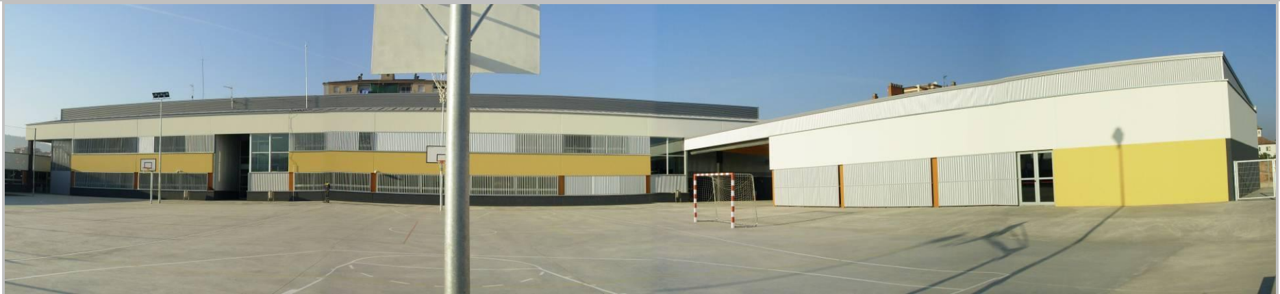
Figura 3 Pati interior, amb totes les finestres cobertes amb làmines regulables
