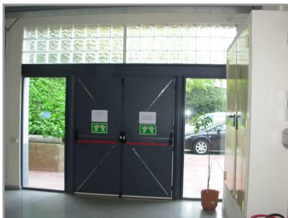
Figura 8 Porta freda d'emergència vista des de l'interior. Els laterals no ajusten
