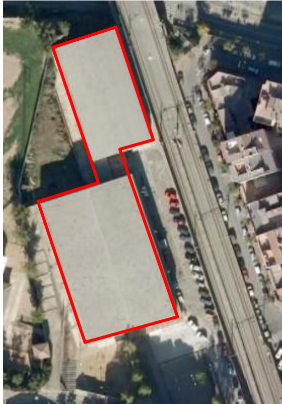
Figura 2 Vista aèria Poliesportiu Sant Josep
