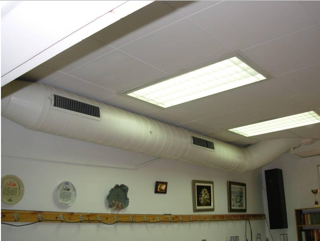
Figura 7 Sistema ventilació
