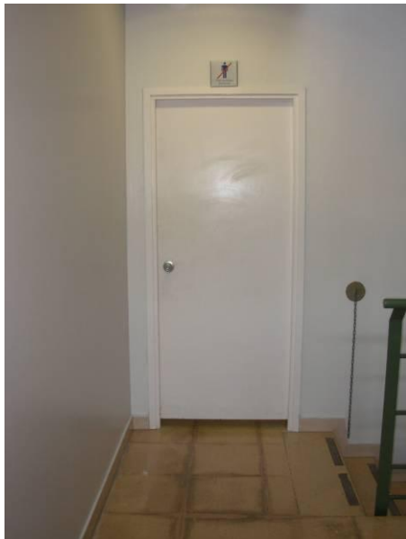
Figura 9 Punts de fuga: Portes de fusta que no ajusten. La Zona de recepció no està tancada ni sectoritzada: el calor de la PB es fuga al 1er pis.
