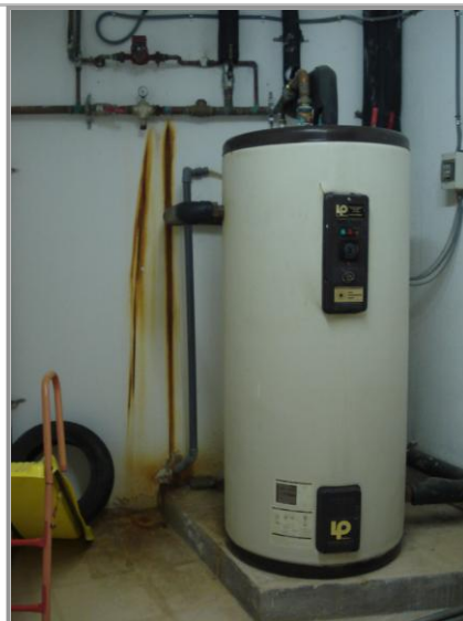
Figura 7 Caldera gasoil convertida per a utilitzar Gas Natural (esquerra). Acumulador situat al gimnàs de 800 l (dreta)
