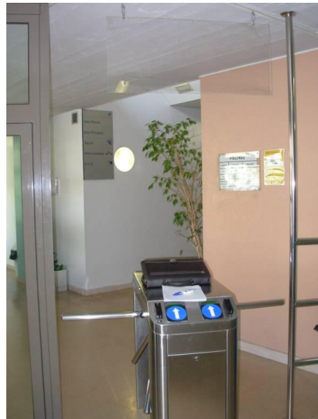
Figura 9 Punts de fuga: Portes de fusta que no ajusten. La Zona de recepció no està tancada ni sectoritzada: el calor de la PB es fuga al 1er pis.
