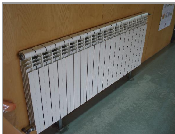
Figura 8 Aerotermos gimnàs (esquerra). Radiador d'alumini de l'edifici principal (dreta)
