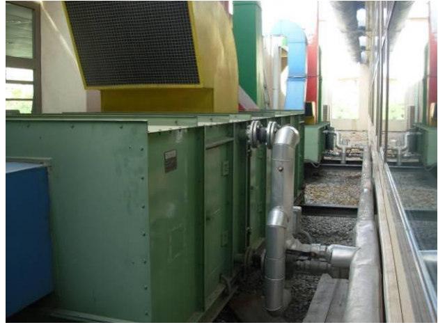
Figura 12 Equip d'aire calent, a través bomba de calor deshumectadora (BCP)
