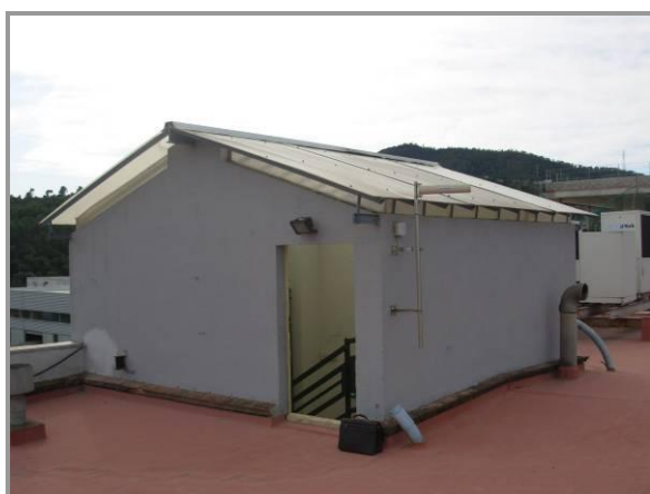
Figura 9 Claraboia de material plàstic
