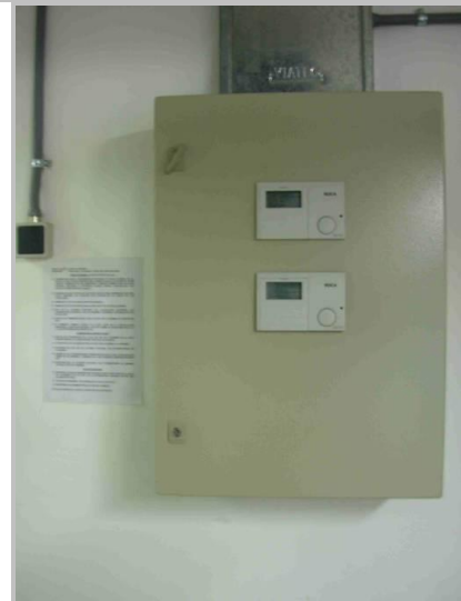
Figura 5 Circuits Climatització (esquerra). Sistema regulació ubicat a la sala de calderes (dreta)
