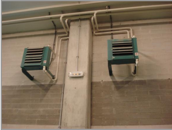
Figura 6 Aerotermos gimnàs (esquerra). Radiador d'alumini de l'edifici principal (dreta). Regulador emissors (fila inferior)
