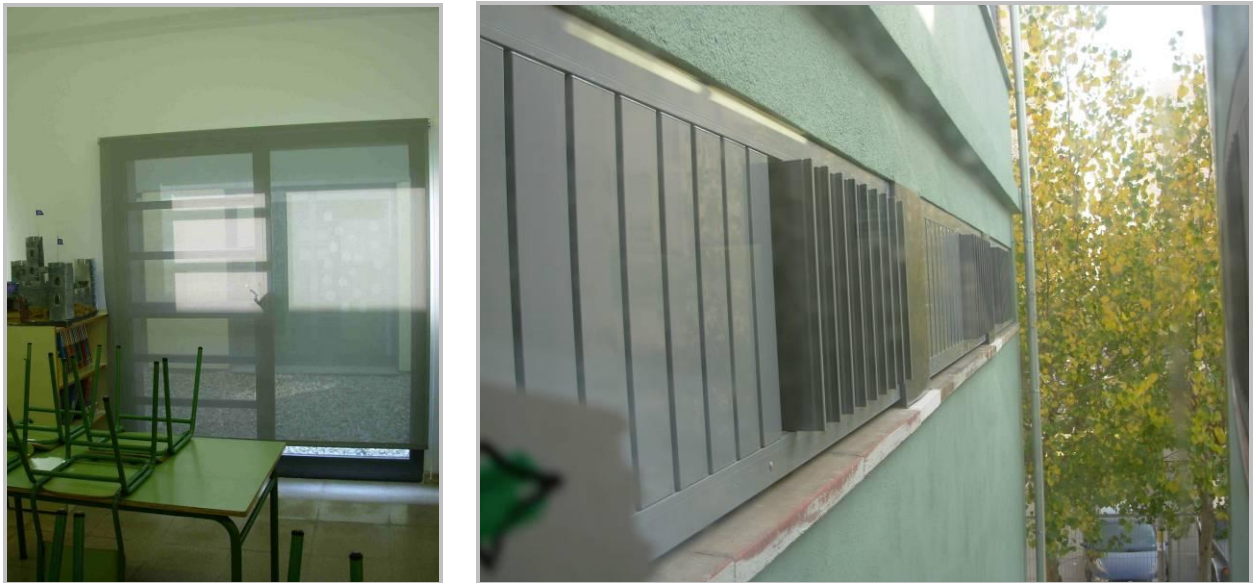
Figura 9 Cortines interiors (esquerra) Lames exteriors (dreta)
