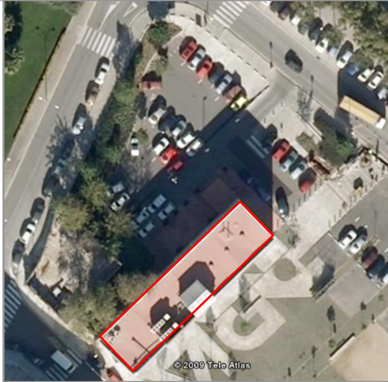
Figura 3 Ortofoto Edifici La Foneria
