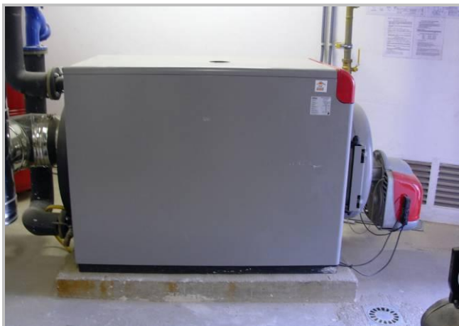
Figura 4 Caldera gas natural (esquerra) Control temperatures (dreta)
