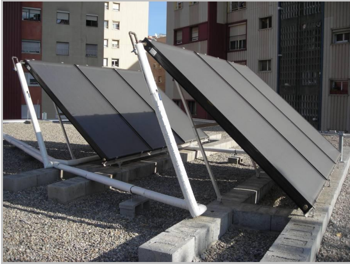
Figura 4 Plaques solars instal·lades al sostre del Gimnàs per a l'ACS
