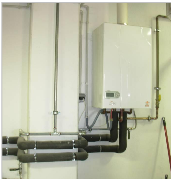
Figura 5. Termo gas natural ACS, en sala calderes (esquerra) Acumuladors (dreta)
