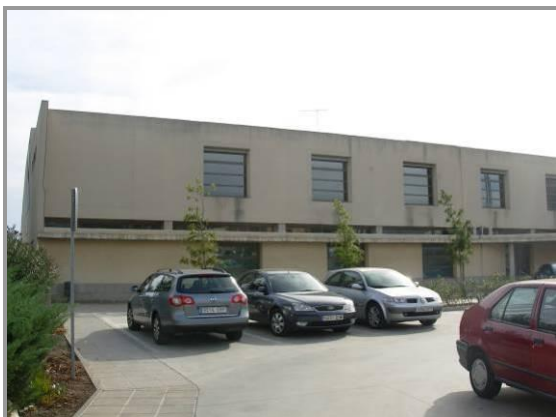
Figura 5 Façana d'accés i pàrking
