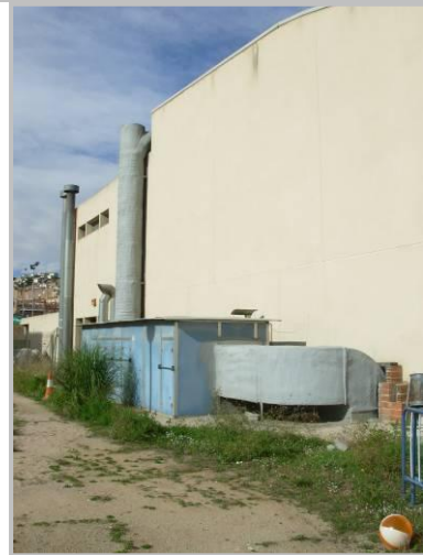
Figura 12 Equip d'aire calent, a través bomba de calor deshumectadora (BCP)
