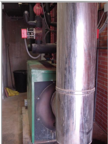
Figura 7 Caldera gasoil convertida per a utilitzar Gas Natural (esquerra). Acumulador situat al gimnàs de 800 l (dreta)
