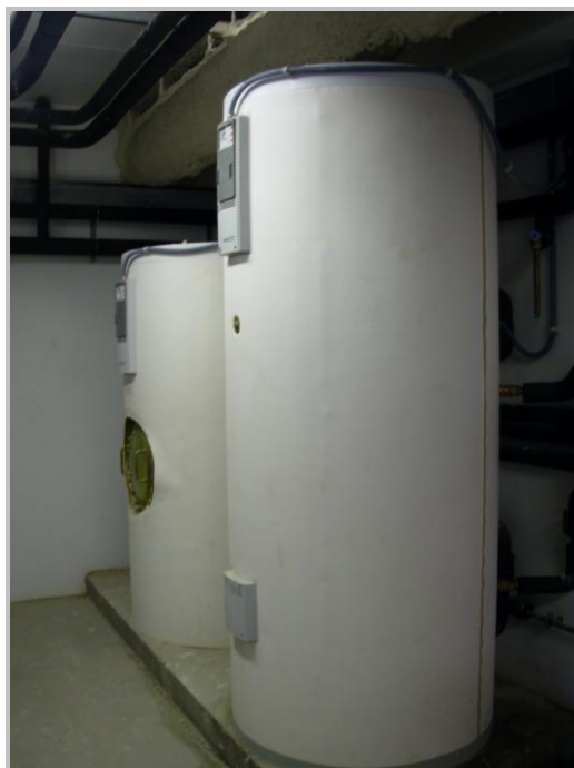
Figura 5. Termo gas natural ACS, en sala calderes (esquerra) Acumuladors (dreta)
