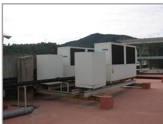
Figura 10 Climatització al terrat. Les dos unitats compresores de les tres plantes i dos extractors d'aire del servidor informàtic
