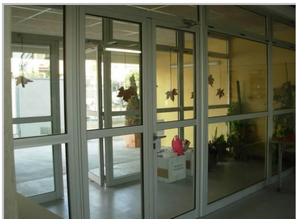
Figura 10 porta doble a l'accés principal, finestres amb doble vidre. Cortines interiors (fila inferior)
