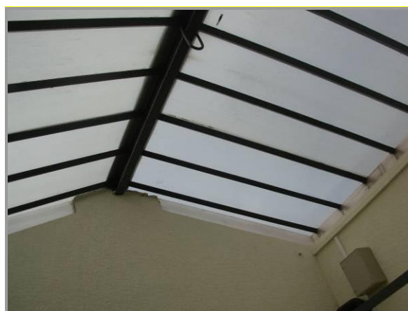
Figura 9 Claraboia de material plàstic
