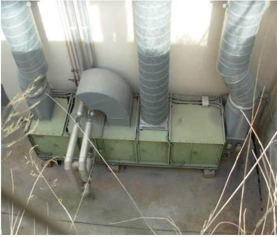
Figura 11 Aparells d'aire condicionat
