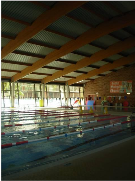
Figura 8 Piscina climatitzada: Paret d'obra a vista, sostre metàl·lic tipus sandwich, vidriera orientada SE i torxes de 1000 V en il·luminaria
