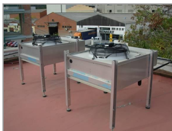
Figura 10 Climatització al terrat. Les dos unitats compresores de les tres plantes i dos extractors d'aire del servidor informàtic
